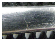
接合部の亀裂 (応力腐食割れ)
